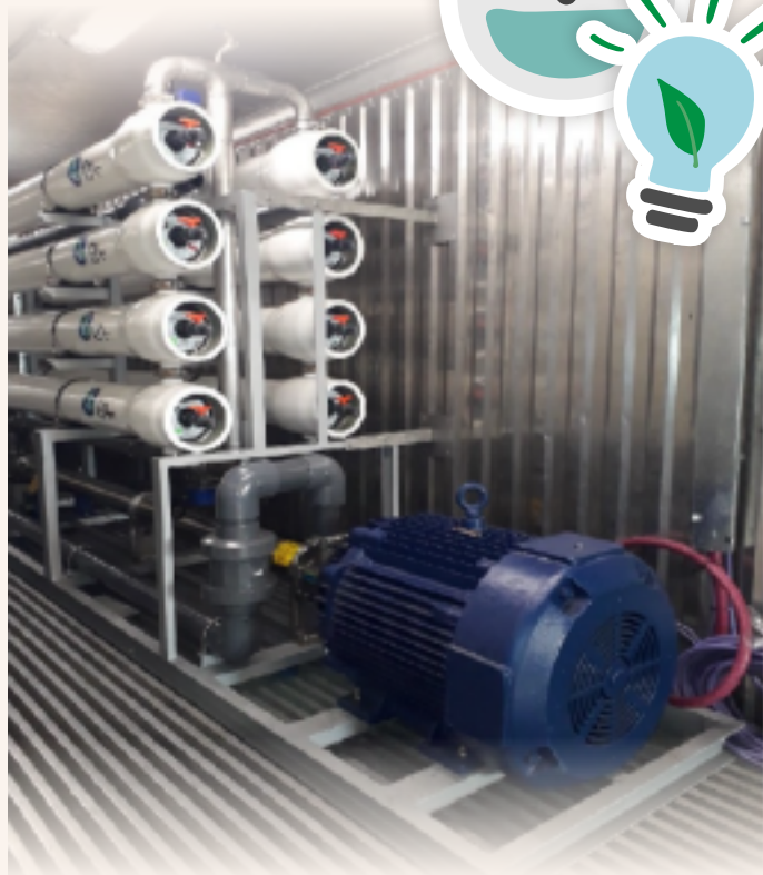
Configuración típica de la tecnología de ósmosis inversa. Fuente: IPA Argentina S.A.
